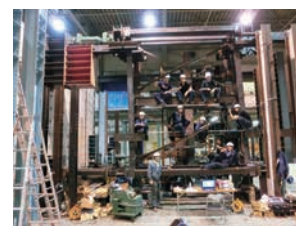
構造特性の把握と損傷評価法の構築を目指した ブレース架構の実大実験 Research on structural behavior and establishment of damage evaluation method for steel braced frames
