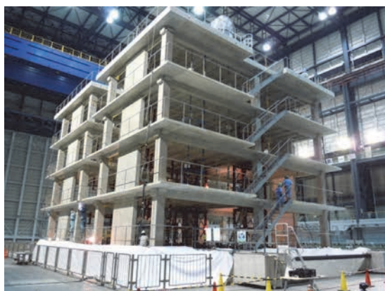
大型振動台を用いた高性能RC造建物の耐震性能確認 Shaking table test on real scale high performance RC buildings
