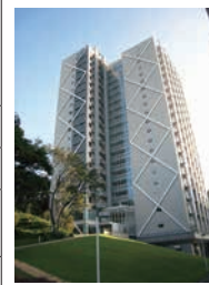
地震・風観測を行っている超高層免震建物(すずかけ台キャンパス)
