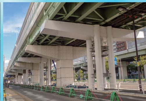
鋼管集成橋脚を活用した既設橋梁の耐震性能向上（西船場 JCT）
