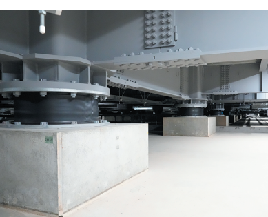
ソニー長崎工場に設置された免震装置
