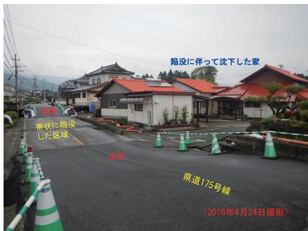
写真 1 狩尾地区で発生した帶状陥没
