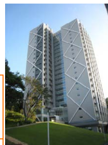
地震・風観測を行っている超高層免震建物（すずかけ台キャンパス） High-rise Isolated Building where Earthquake and Wind Observation are Carried
