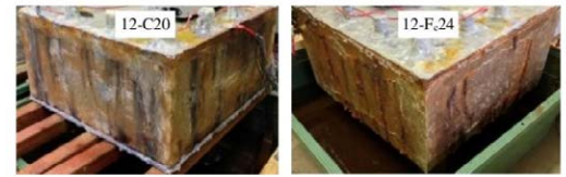
かぶり厚とコンクリート強度による腐食ひび割れ性状の違い Corrosion crack behaviors depending on cover depth and concrete strength
